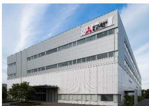
Byggnaden för Industrial Mechatronics Systems Works (i Nagoya Works område)
