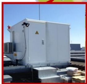
Terminaldopplerlidar För att känna av vindskjuvning vid väderförhållanden utan nederbörd
