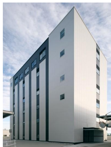
”TAKUMI”-utbildningscentret för installation
