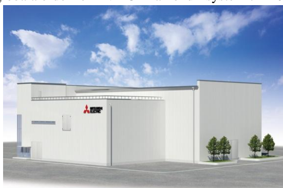
Bild av Mitsubishi Electrics kontrollanläggning för högspänd likström
