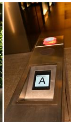
Användarens tilldelade hiss visas på säkerhetsgrindens LCD-indikator
