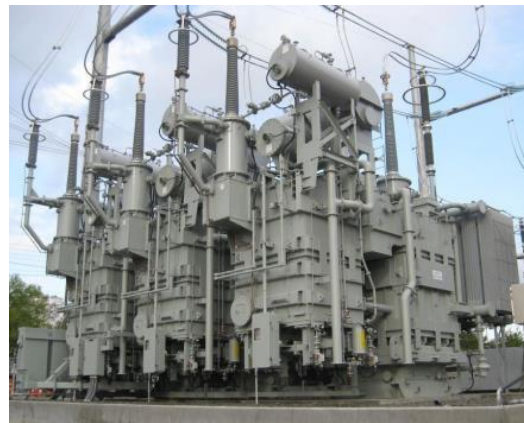
Speciell uppdelad trefastransformator
